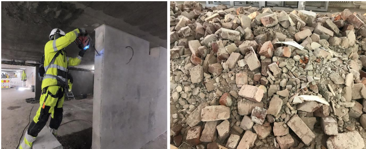
Figur 1: Typiske arbeidsoppgaver som er målt på: pigging (a), Rydding av store mengder bygningsavfall (b). FOTO:Torunn Ervik
