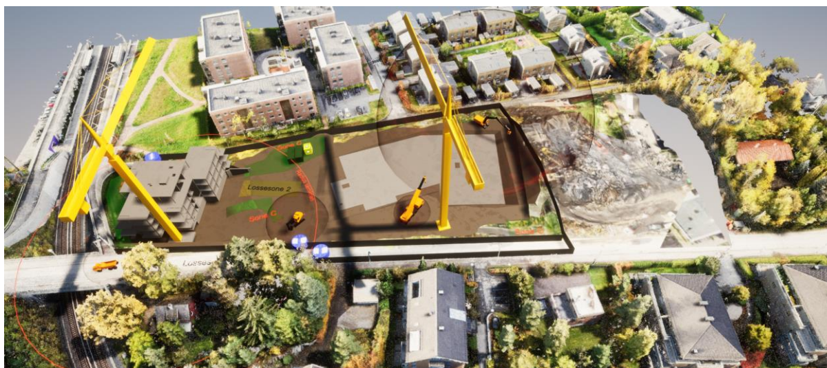
Figur 2-5: Oversiktsbilde av byggeplass med støykilder og annet utstyr
